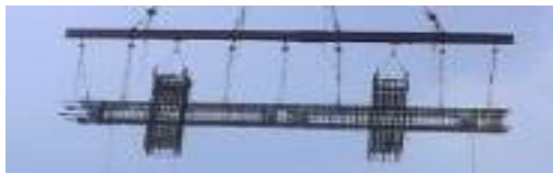
安藤建設 サッポロビール跡地開発 久米設計 地組セット長スパン交差部 (十字型)
