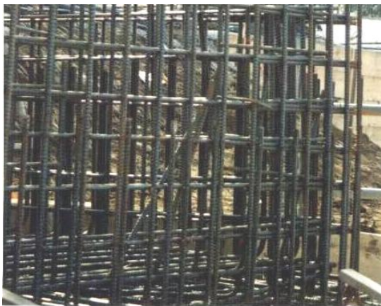
真柄建設 リーベスト勝田台 総合研究所 壁構造の出隅部分の納め
