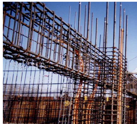
飛島建設 グリーンハイツ八千代 ゼファー 先組工法で被りを安全に
