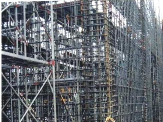
西松建設 龍ヶ崎ごみ処理場 NKK (シビルエン) 1F柱及び壁全て先組み
