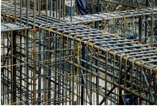
太平工業 グスキン横浜工場 川口構建設計 基礎梁交差部の納めと補強関係
